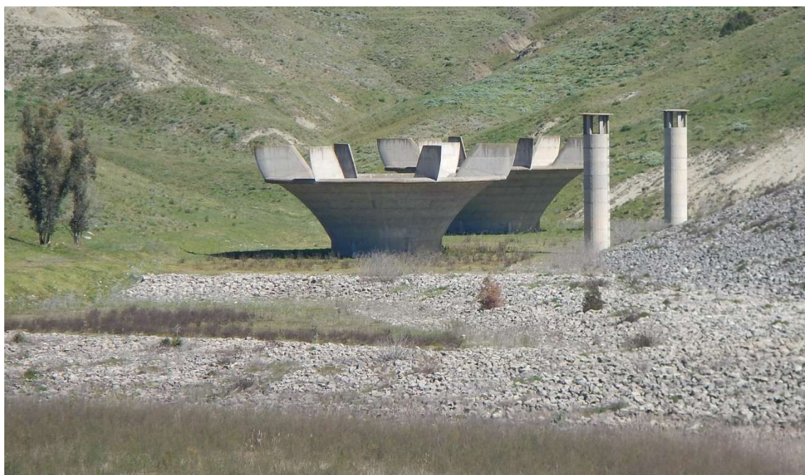
Figura 3.5: Sfiatori a calice e torrini aerofori
