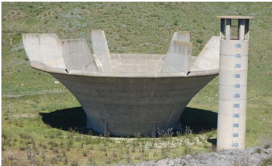
Figura 3.4: Sfiatore a calice sinistro e relativo torrino aeroforo
