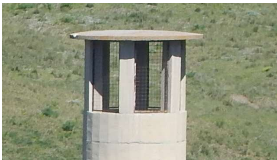
Figura 8.3: Torrino aeroforo – Particolare dell'estremità superiore con la rete metallica
